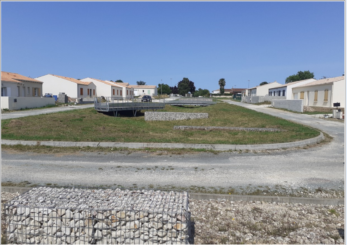
Bassin pluvial intégré - Lotissement « Les Tilleuls » à Saint-Hippolyte
