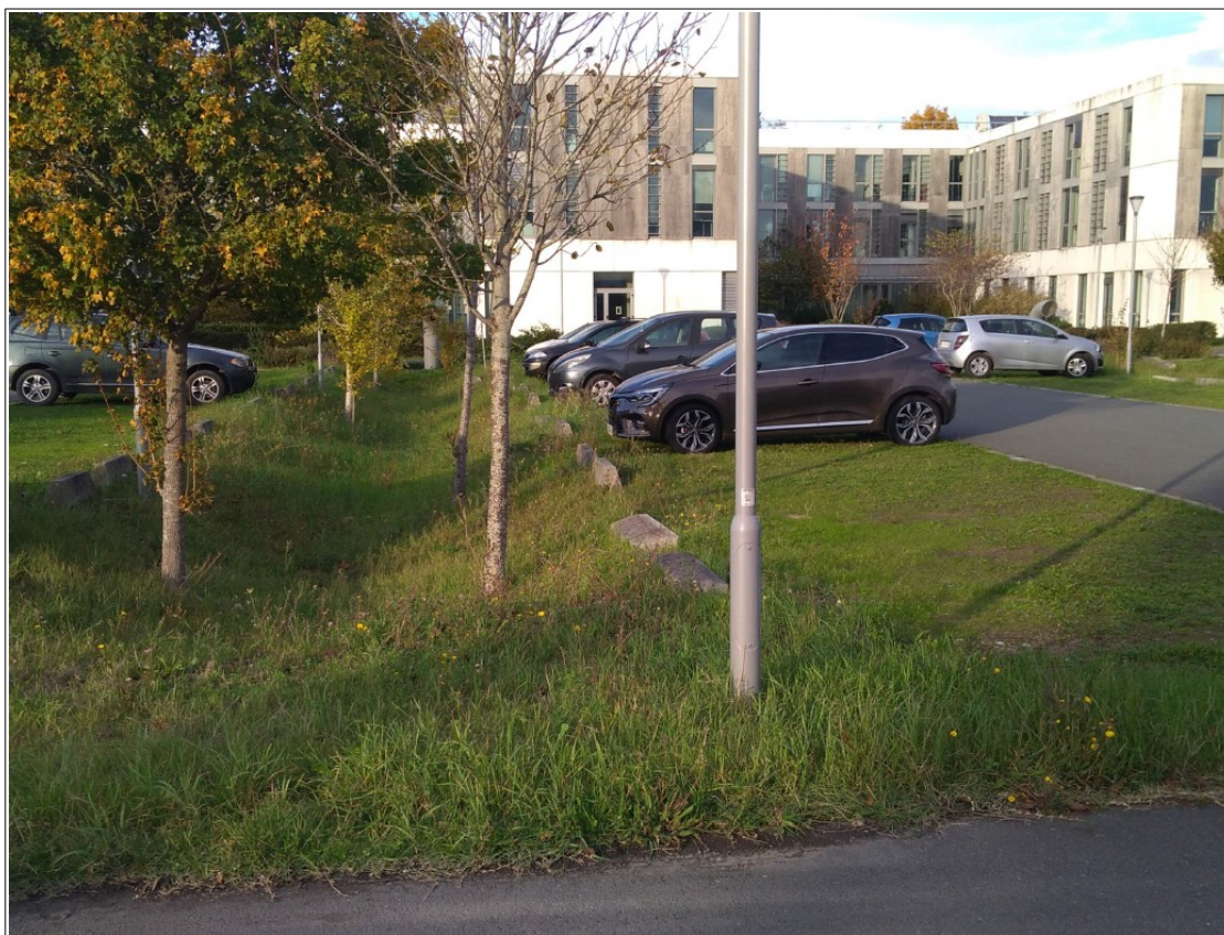
Parking enherbé avec noue centrale – DDTM 17 à La Rochelle
