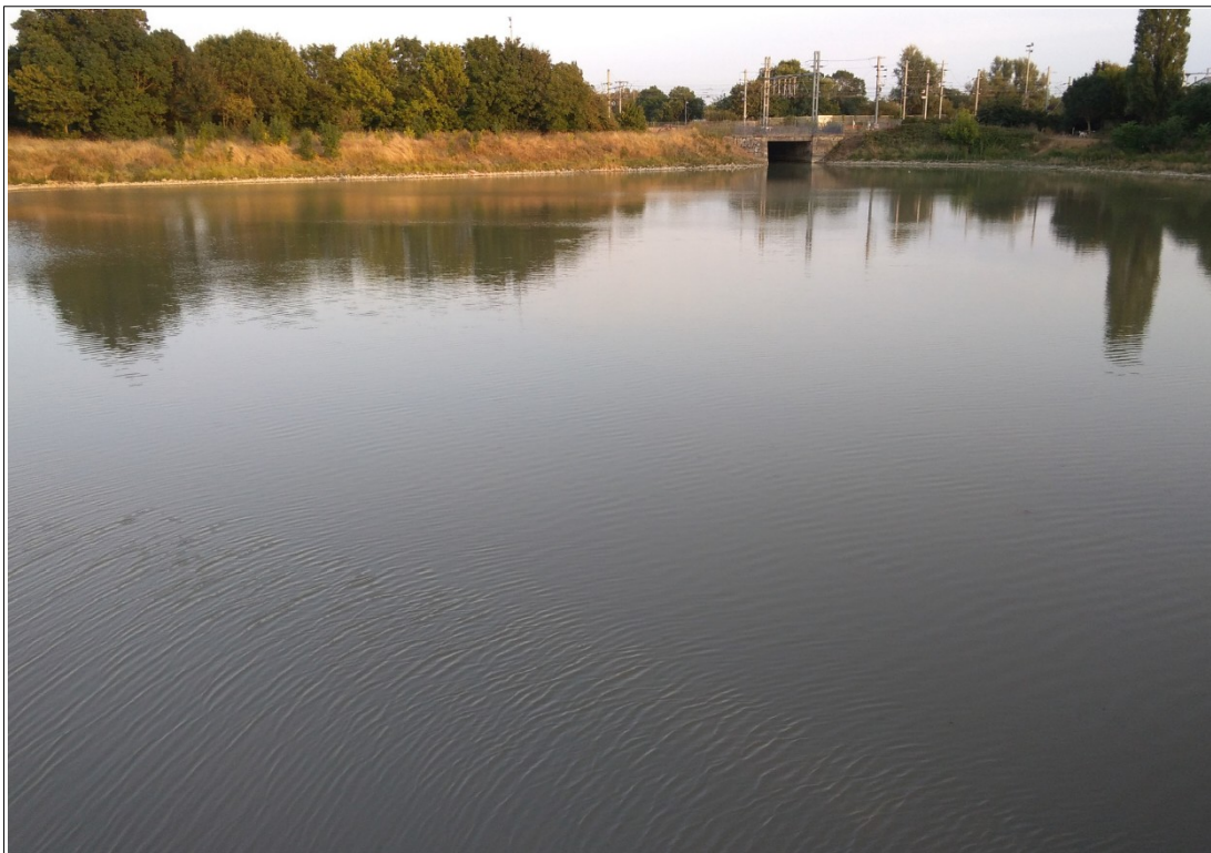
Bassin d'eaux pluviales des Chasses à La Rochelle
