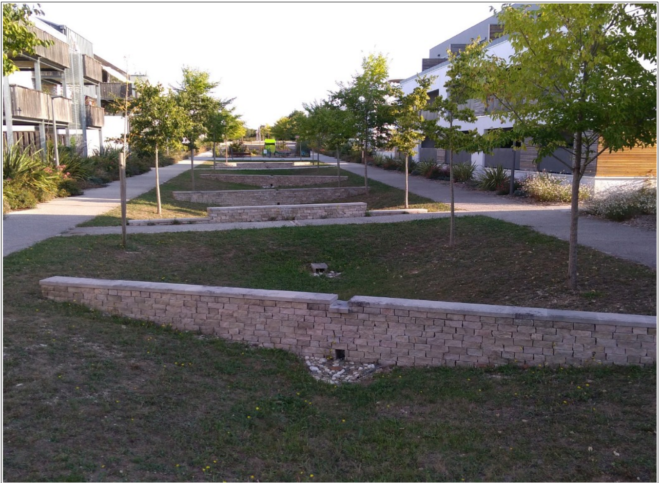
Lotissement avec gestion des eaux pluviales intégrée aux espaces verts à Périgny
