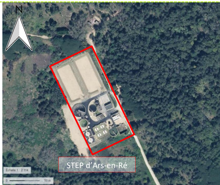
Figure 3 : Vue aérienne du site de la station d'épuration d'Ars-en-Ré – Source : Géoportail
