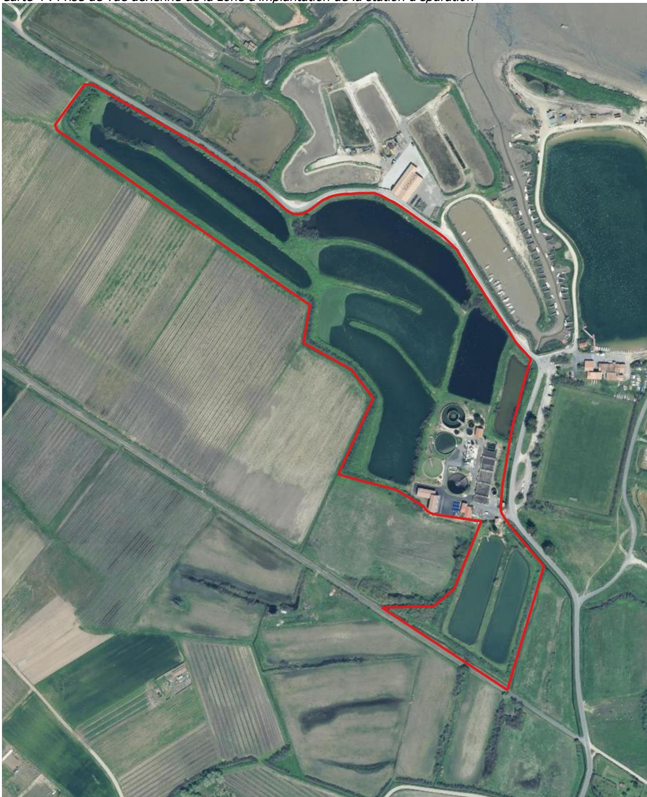
Carte 4 : Prise de vue aérienne de la zone d'implantation de la station d'épuration
