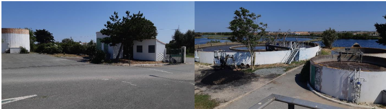
Figure 50 : Photographies des ouvrages de traitement
