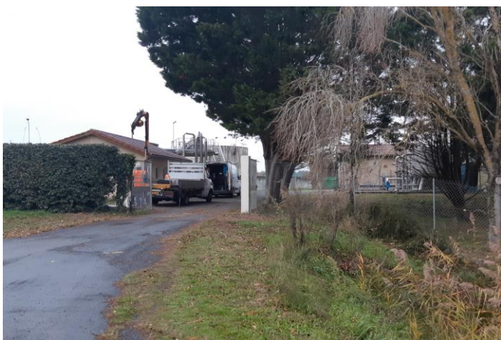
Photo 3 : Entrée de la station d'épuration (Novembre 2021)
