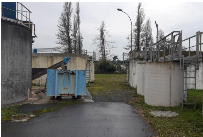
Photo 5 : Ouvrages de traitement (Novembre 2021)
