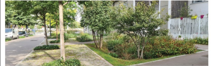
Exemple d'une noue en pleine terre - Saint-Duen - Source : Urbanwater
