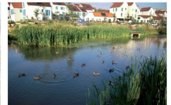
Exemple d'un bassin assurant la collecte des eaux pluviales - Auxer Source : Urbanwater
