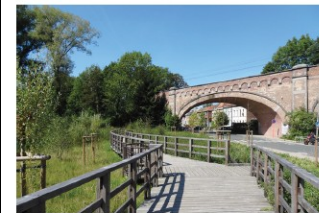
Exemple d'une zone inondable végétalisée - Uccle - Source : Urbanwater
