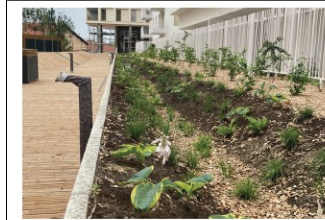
Exemple d'une noue sur dalle en coeur de quartier Asnières-sur-Seine - Source : Urbanwater
