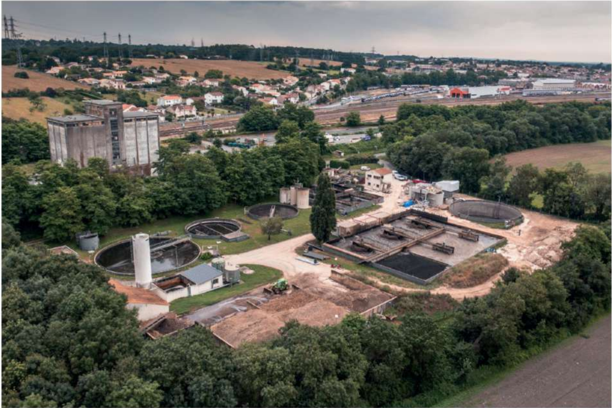
Photographie de la station d'épuration
