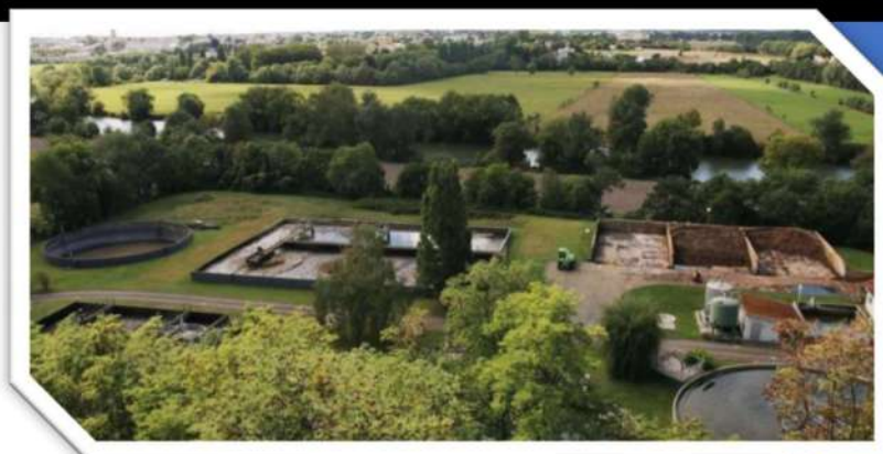
Station d'épuration de Saintes Vue du silo – Source Sud-Ouest
