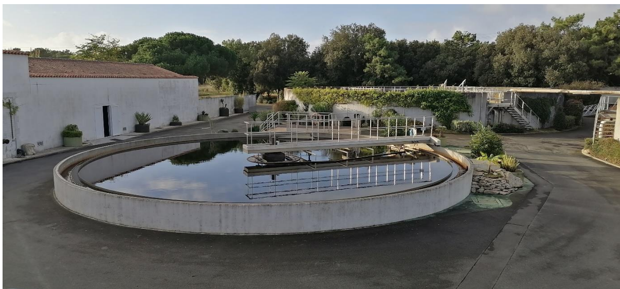
Vue du clarificateur – Source Maîtres Cubes
