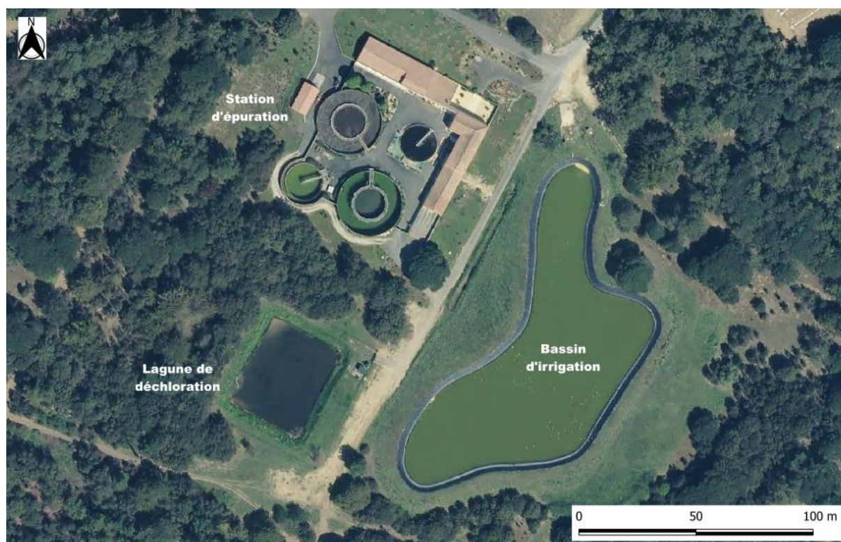
Figure 10 : Vue aérienne de la station d'épuration de La Flotte-en-Ré (source : Géoportail)
